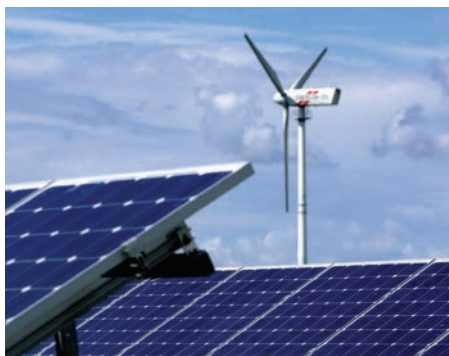
Das Hybridkraftwerk kombiniert Sonnen- und Windstrom.
