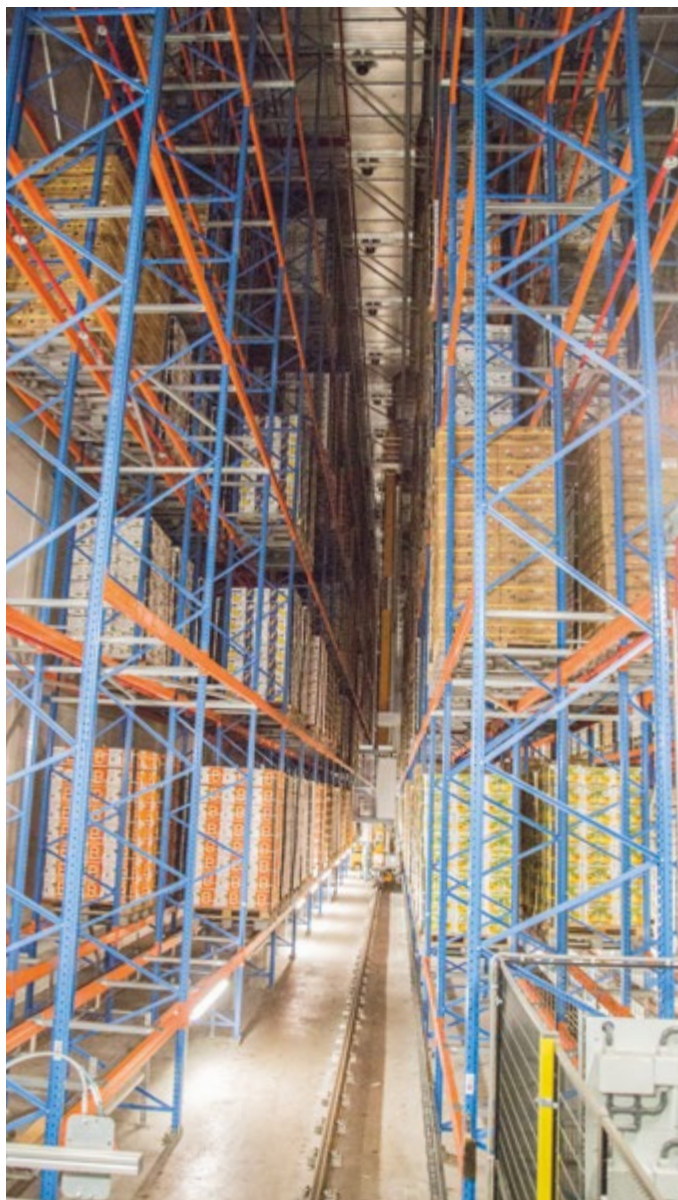
Das Herz der Anlage: Das vollautomatische Kühlager
