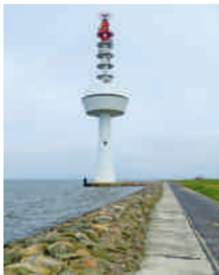
ORIENTIERUNG: Der Radarturm Neuwerk gewährleistet eine sichere Schifffahrt auf der Elbe.
