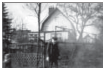
Das Praxishaus mit erstem Anbau ca. 1935
