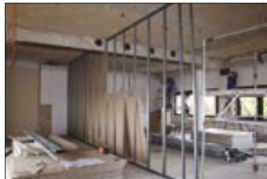
Die neue Zwischenwand wird gezogen.
