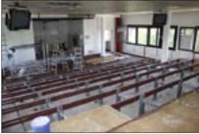
Der Hörsaal des Fortbildungszentrums wird demontiert.
