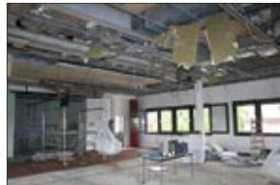
Das gesamte Innenleben des Raumes wird demontiert.
