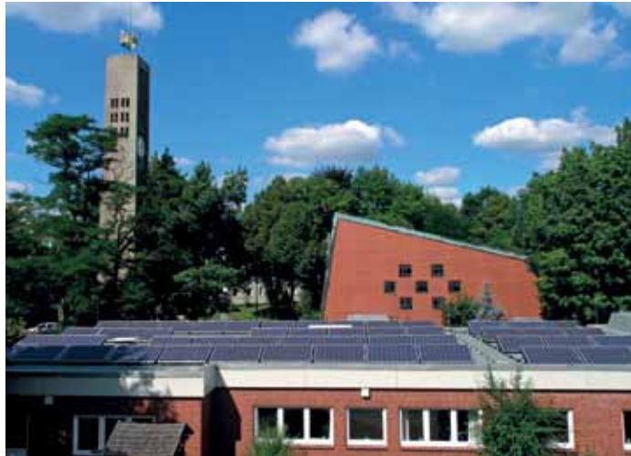
Seit 2008 ist die Photovoltaik-Anlage auf dem Dach des Gemeindehauses.
