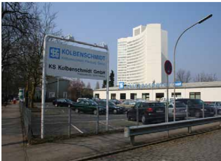
Parkplatz und Frontansicht des Kolbenschmidt-Geländes in Ottensen
