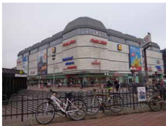
Bausünde Altonaer Bahnhof heute: Ein „Kaufhaus mit Gleisanschluss“ Foto: Kaeser
