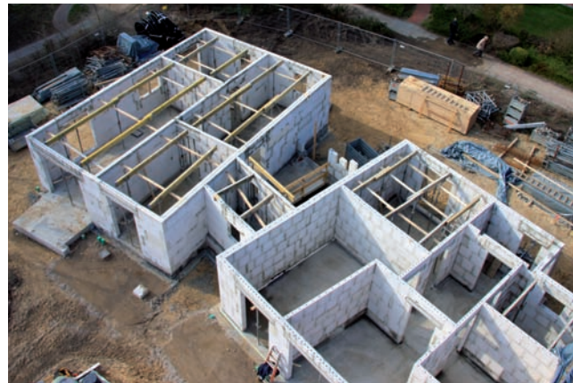
Zu keinem Zeitpunkt ist der Baufortschritt besser sichtbar als während der Rohbauarbeiten:
