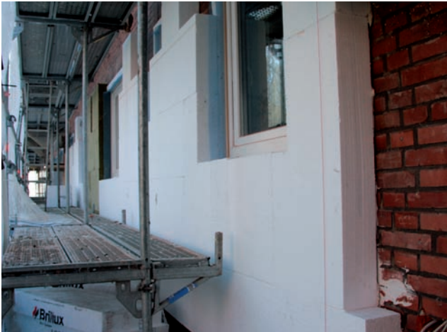
Die Styropordämmung wird direkt auf das alte Verblendmauerwerk geklebt. VE 10, Dieselstraße 30 – 38 u. a. in Barmbek.
