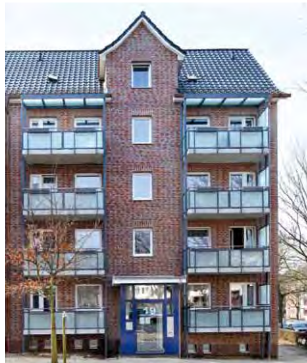
VE 60, Tischbeinstraße u. a. in Barmbek nach der Modernisierung
