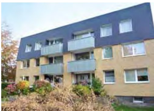
Holsteiner Chaussee 213 in Schnelsen nach der Modernisierung
