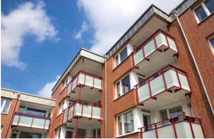
Auch im Lüdersring wurde die ursprüngliche Backsteinoptik durch den Riemchenverblend erhalten
