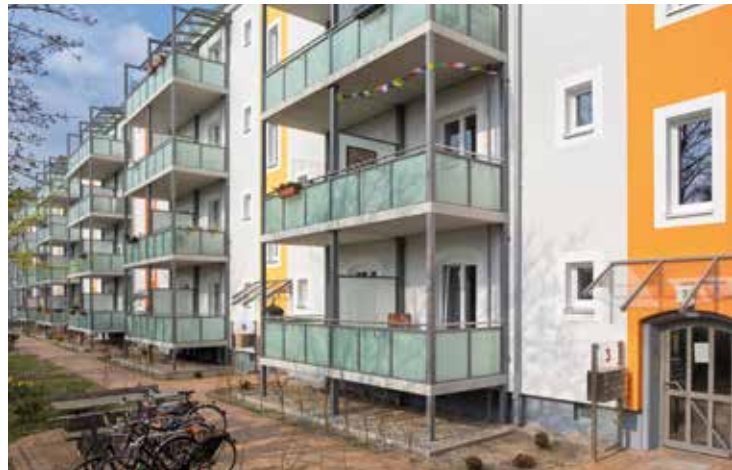
VE 56 + 57: Neue Balkone und ein neuer Anstrich werten das Objekt auch optisch auf
