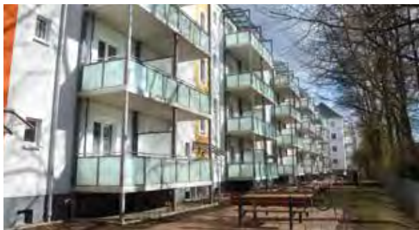
VE 58: Nach Beendigung der Fassadenarbeiten wurden die Balkone aufgestellt und in der Fassade verankert
