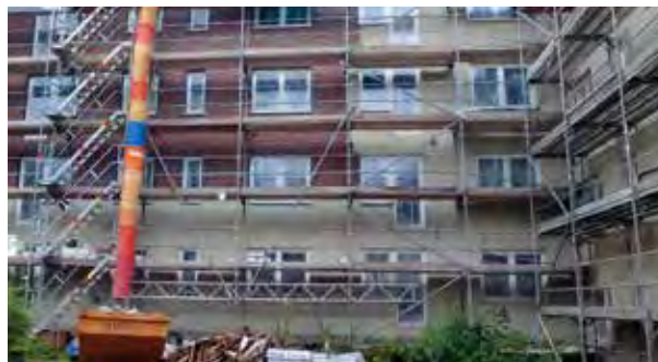
VE 62: Während der Fassadenarbeiten
