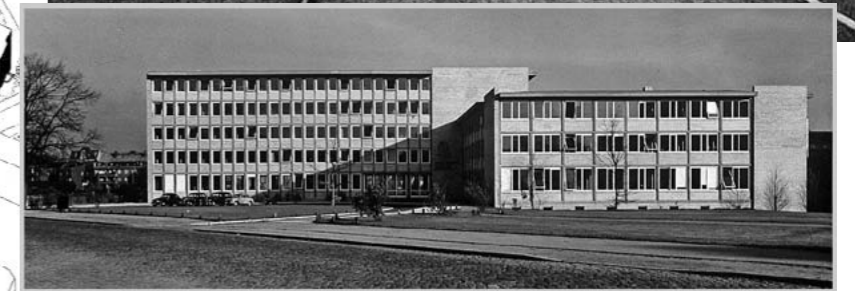
Oben: Blick von der Robert-Koch-Str. auf das Bezirksamt Links: Isometrie vom 1. und 2. Bauabschnitt, undatiert 1952 Unten: Blick vom Reinckeplatz auf das Bezirksamt
