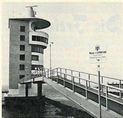
Entlang des 120 km langen Elbe-Schiffahrtsweges sind elf Radarstationen errichtet worden. Das Bild zeigt die Radar-Zentral-Station an der „Alten Liebe“ in Cuxhaven.
