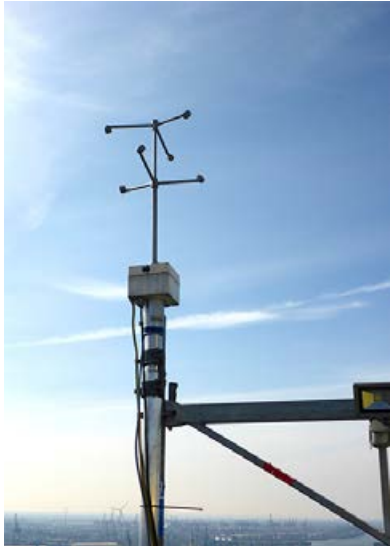
Der neu installierte Windmesser ist am Turmkreuz montiert und nimmt zwanzig Messungen pro Sekunde vor. Foto: UHH/CEN
