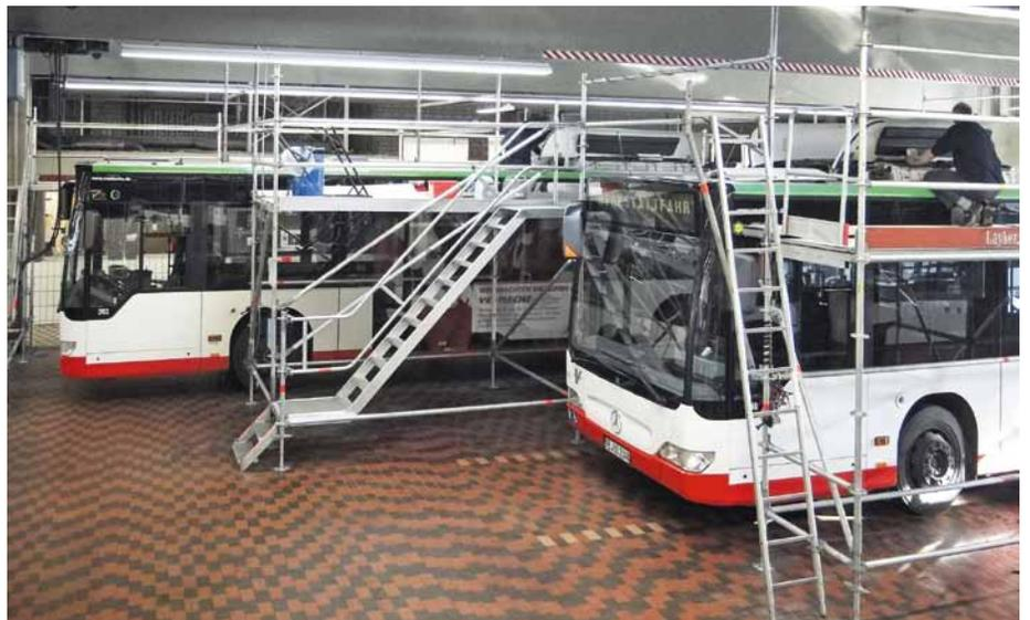
Treppen ermöglichen einen sicheren Zugang zur Arbeitsbühne auch mit Material und Werkzeug.
