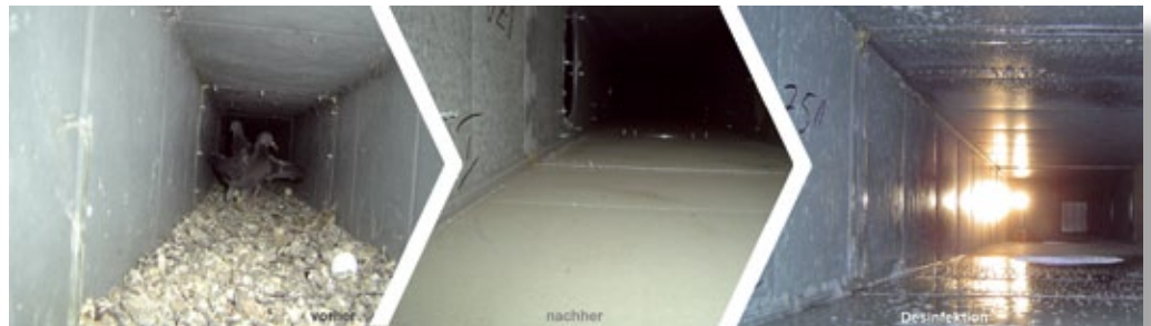
Reinigung Luftkanal - Vorher/Nachher. (Foto: NIEDERBERGER Gruppe Verwaltungs-GmbH)
