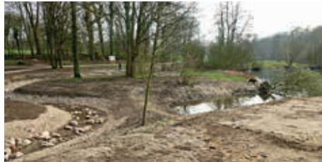
Bild 6. Links die verlegte Flottbek, rechts der Überlauf in den Teich. Darunter soll sich eine Sumpfbzone entwickeln. Der umgestürzte Baum ist schon ein Teil davon.
