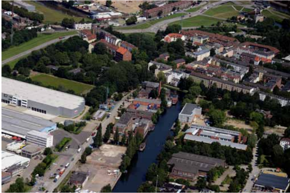
Die Veringhöfe während der Umbauzeit im Juni 2013. Vogelperspektive von Süden. Auf der westlichen Seite des Veringkanals vorne links die Spedition Hellmann, schräg gegenüber die Honigfabrik. Östlich des Kanals im Vordergrund die Zinnwerke, im Hintergrund Teile des gründerzeitlichen Reiherstiegviertels.
