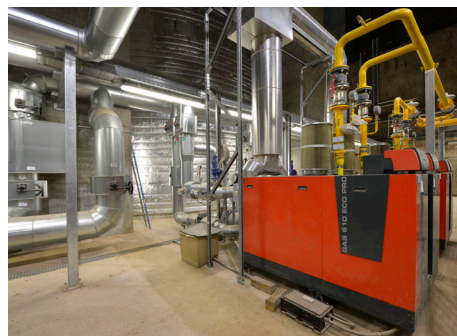
Abb. 28-33: Einbau Spitzenlastkessel, Montage Solarkollektoren, Installation Blockheizkraftwerk
