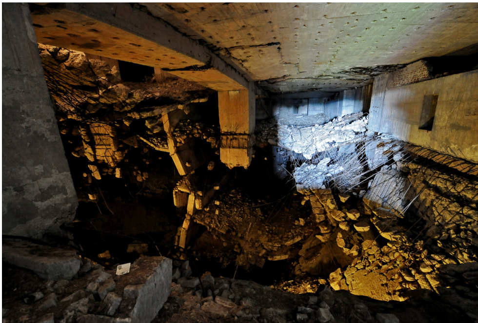
Abb. 4: Aufnahme des gespenstigen Innenraums aus dem Jahre 2009
