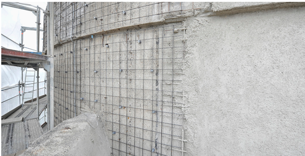
Abb. 27: Anbringung des Spritzbetons auf der Außenfassade
