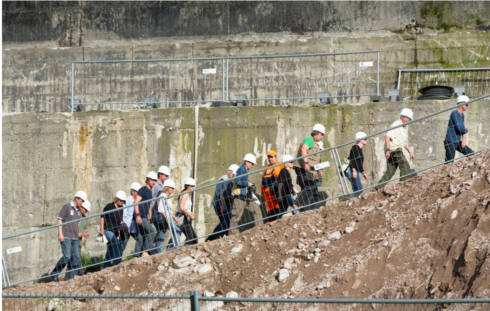
Abb. 42: Eine Gruppe von Besuchern auf dem Weg in das Innere des Bunkers während der Umbauphase
