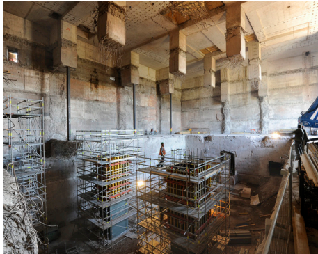
Abb. 25: Oben die Reste des historischen Tragwerks
