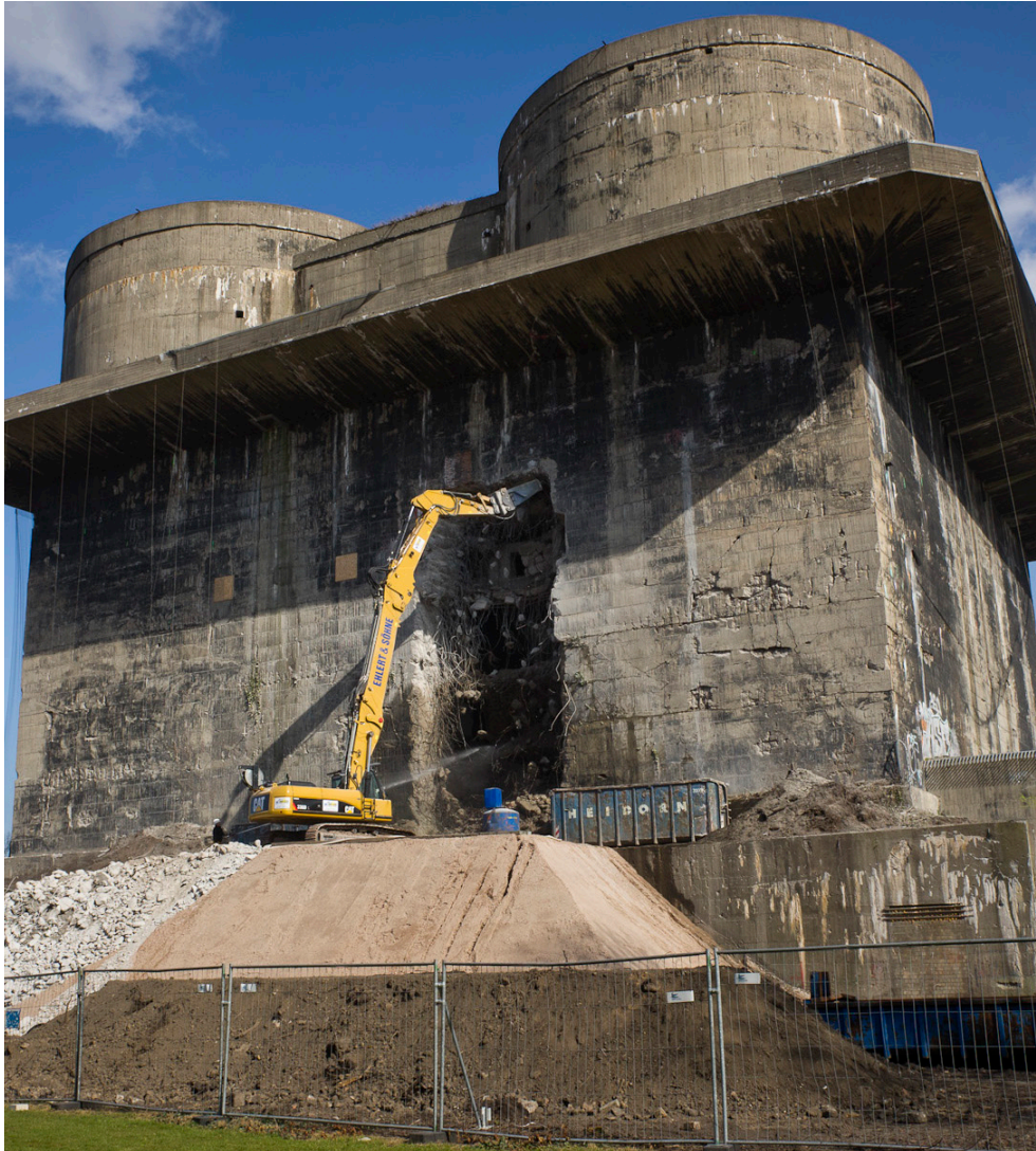
Abb. 24: ...ein entsprechender Durchbruch geschaffen werden.
