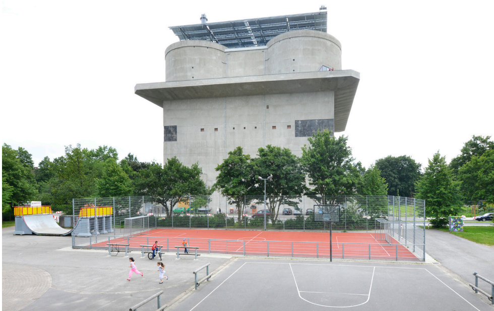
Abb. 13: Der fertiggestellte Energiebunker Mitte 2013
