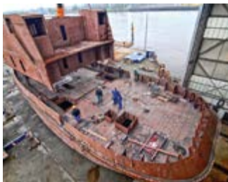
BAUSATZ: Ein Kran setzt das Deckshaus auf den Schiffsrumpf auf.
