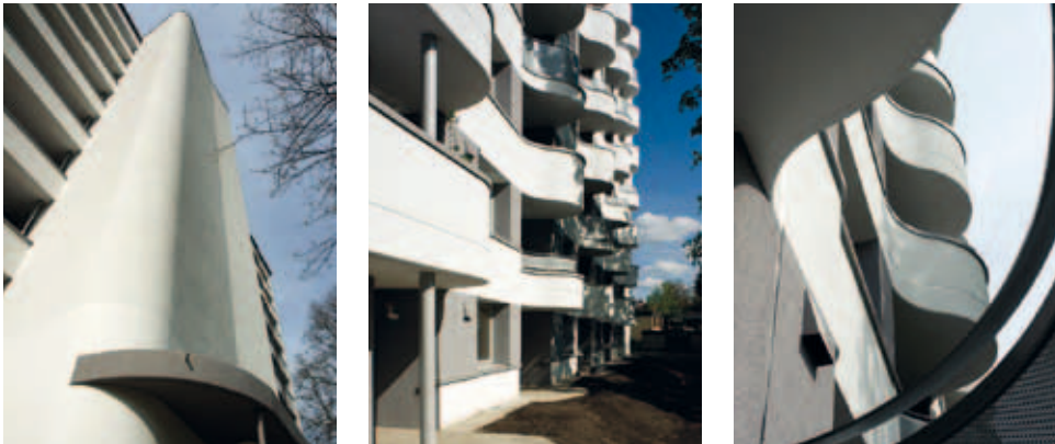
Die Fluwog hat für die Sanierung den Deutschen Fassadenpreis bekommen.
