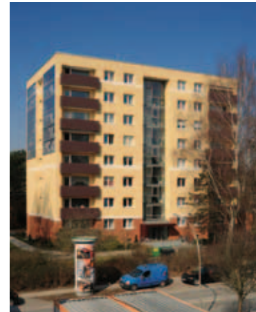
Auszeichnung für die größte Fassaden-Solaranlage in Hamburg: 121 m 2 Anlagenfläche unterstützen die Warmwasserversorgung für 40 Mietwohnungen in Schnelsen.
