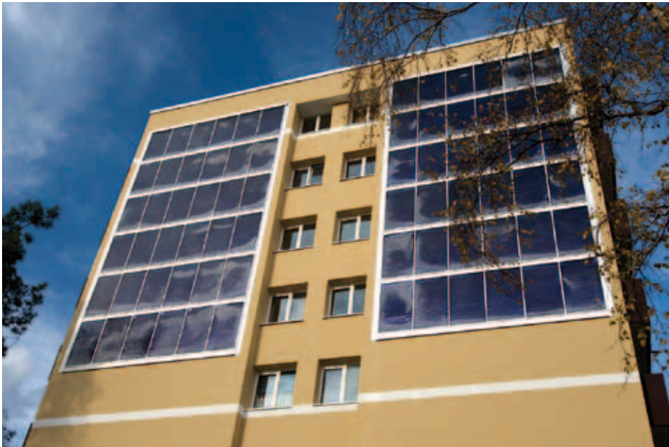
Auszeichnung für die größte Fassaden-Solaranlage in Hamburg: 121 m 2 Anlagenfläche unterstützen die Warmwasserversorgung für 40 Mietwohnungen in Schnelsen.
