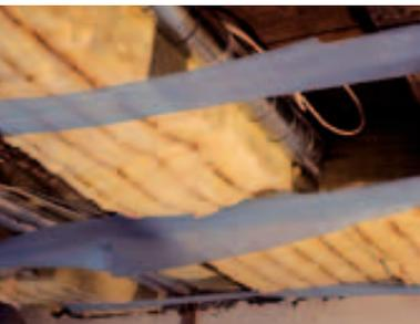
Die unterste Geschossdecke wurde als Teil der Gebäudehülle mit Mineralwolle gedämmt.
