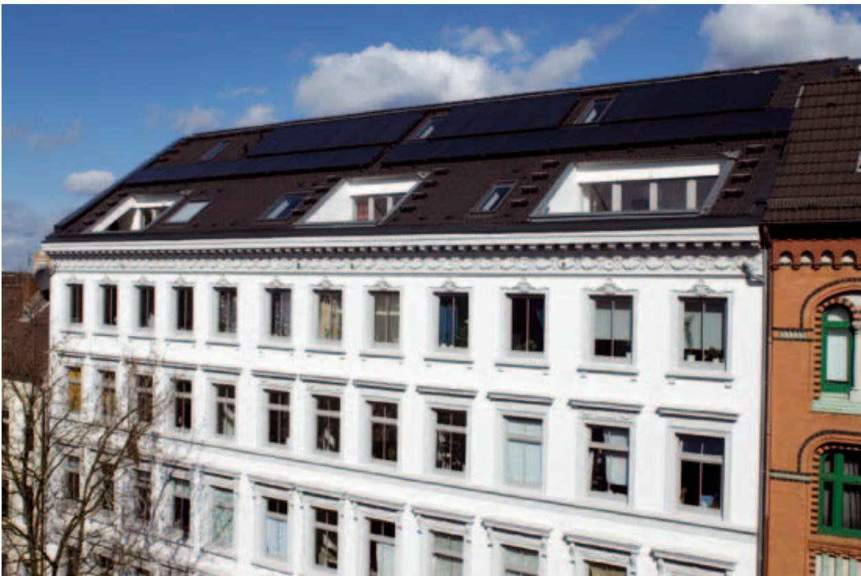
Die Fenster der sanierten Straßenfassade haben eine Doppelverglasung und aufgesetzte Sprossen. Auf dem Dach nutzt eine Solarthermie-Anlage das Sonnenlicht.
