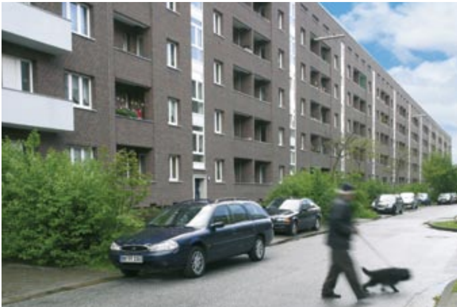
Veddel Modernisierung von 210 Mietwohnungen aus den 1920er Jahren, Fassadendämmung unter Beibehaltung der Rotklinker-Optik
