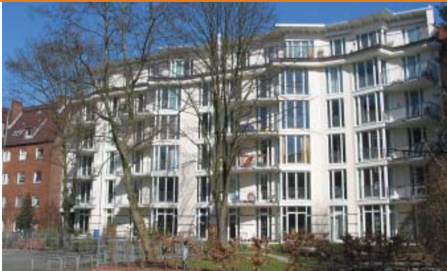
Lutterothstraße 39–40, Fertigstellung 2002, Wohnungseigentum
