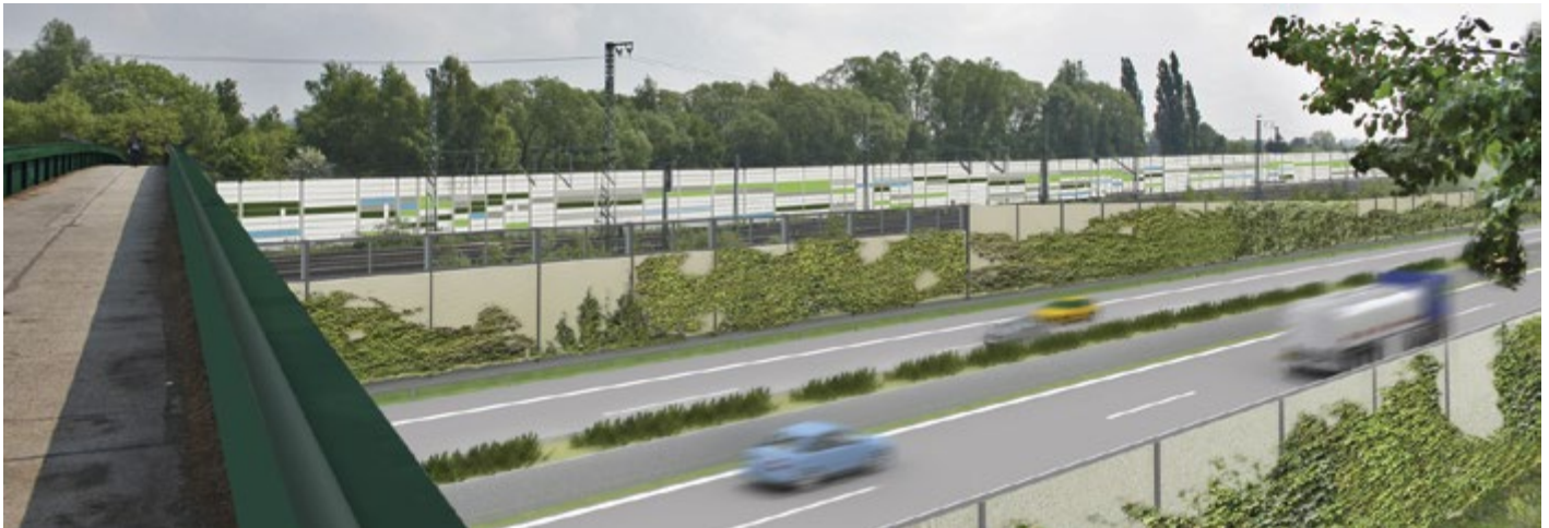
Blick auf die nun großzügig ausgebauta Reichsstraße mit Standstreifen und zeitgemäßem Lärmschutz.
