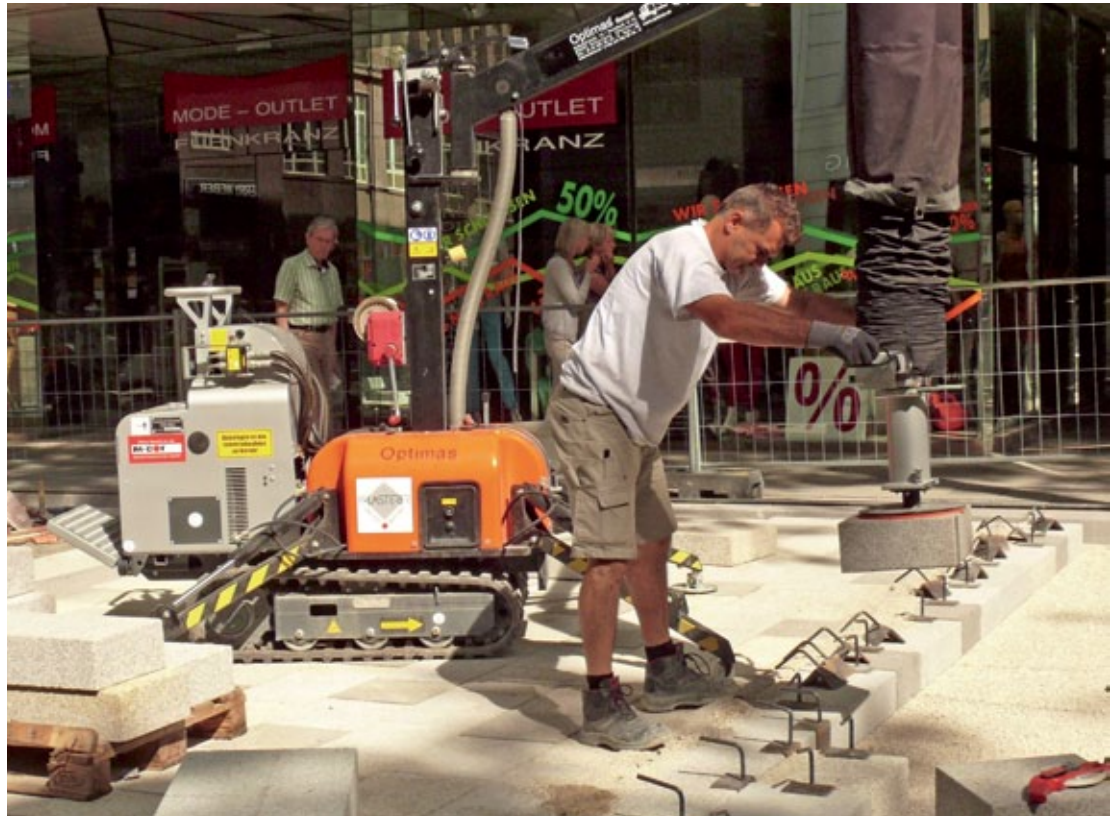
Das Optimas Vacu-Mobil Allrounder hebt bis zu 200 kg über 3 m; kontinuierlicher Einbau, wie hier in der Fußgängerzone Mariahilfer Straße in Wien, ist dadurch möglich. (Foto: Optimas GmbH)
