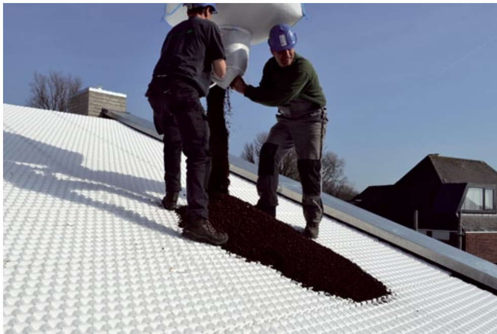
Das neue Optigrün-Schubsicherungssystem Typ P (Platte) in der Einbauphase. (Foto: Optigrün)
