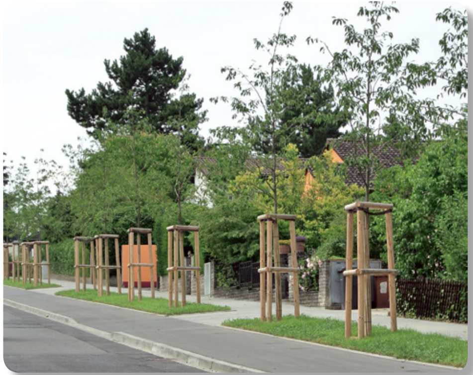
Für die Mannschaft der GaLaBau-Firma Baier war die Errichtung dieser Mustergärten 1. In Würzburg wurden Baumpflanzungen in ansehnlichen Umfang durchgeführt. Die Verankerung ist eine „Besondere Leistung“ und muss extra ausgeschrieben, kalkuliert und abgerechnet werden. eine Gewaltanstrengung. Firmenchef, Thomas Baier, (2. von li.) kann auf seine Leute stolz sein. (Fotos: Hans Beischl)
