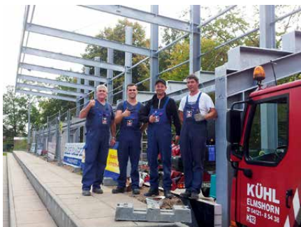
Stolz auf ihr Werk sind die Monteure der Hermann Harden GmbH. Dreieinhalb Monate betrug die Bauzeit für die Tribüne.
