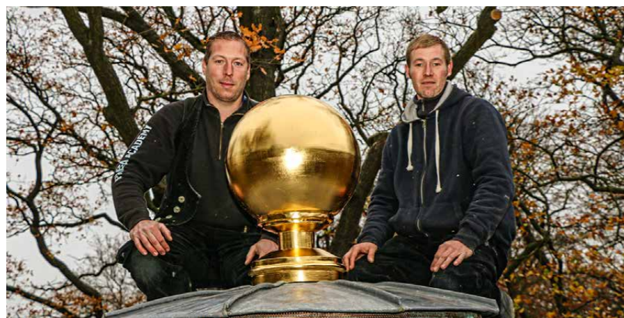
Marco Jaekel und Patrick Reiser von der Schweriner Wibau GmbH montierten die Kugel.
