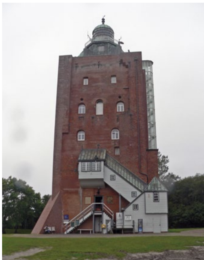
Der im Jahr 1310 fertig gestellte Wehrturm ist das älteste Bauwerk Hamburgs.
