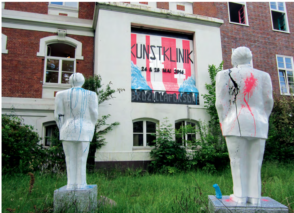
Das ehemalige Krankenhaus Bethanien wird umgebaut für Baugemeinschaften, eine Wohn-Pflege-Einrichtung für Demente sowie für eine Tagesklinik.
