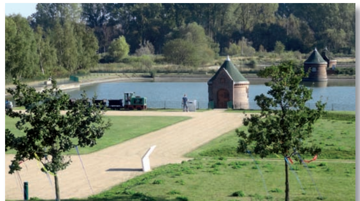
Klärbecken mit Schieberhäuschen
