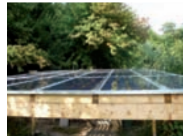
Carport-Dach mit Energiegewinnung
