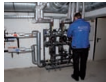
Pielström-Heizungsexperte bei der Arbeit
