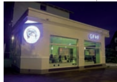
Das Büro der GFHF Architekten
