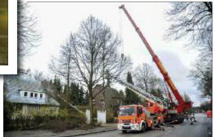
25.12.2014, DRZF, WANDSBEK: Birke auf Einfamilienhaus gestürzt, aufwendiger Abtransport mittels DL, Feuerwehrkran und vereinten Kräften
