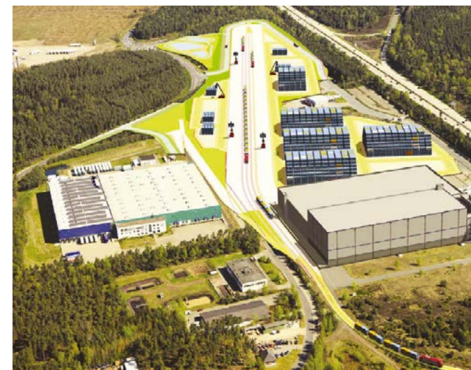
Die perfekte Lage für norddeutsche Logistik-Dienstleistungen: Soltau Logistic Center
