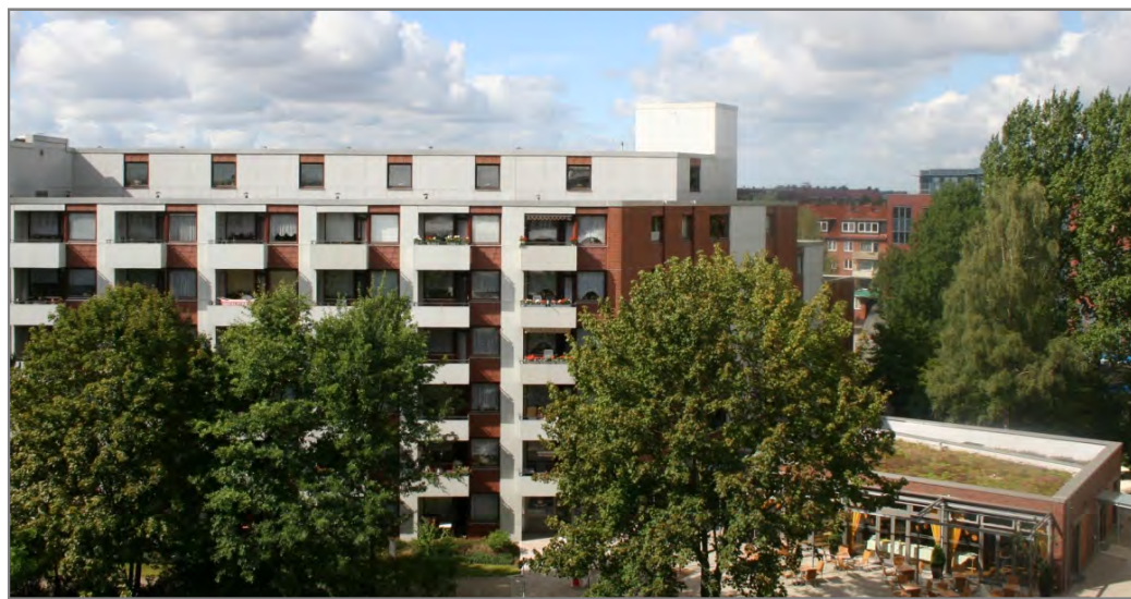
Beschluss: Das Dach von Haus 2 wird ausgebaut und neue Wohnungen entstehen
