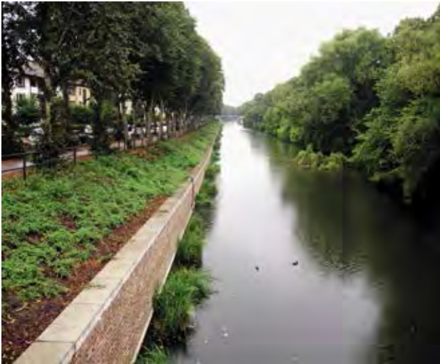
Abb. 5.9: Alstersystem: Eilbekkanal in Nähe zur Brücke Richardstraße (Foto: Ralf Thiel).
