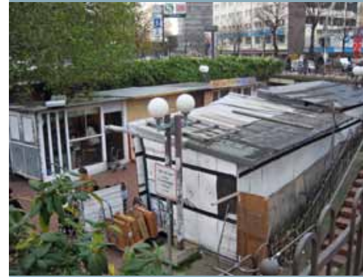
Verkaufsstände vor der Grunderneuerung des Tunnels
