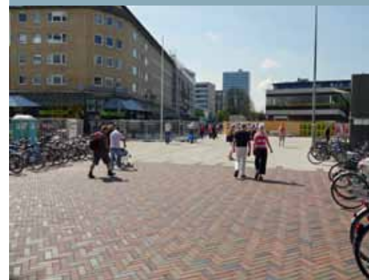
Noch ist der Goetheplatz eine Baustelle
