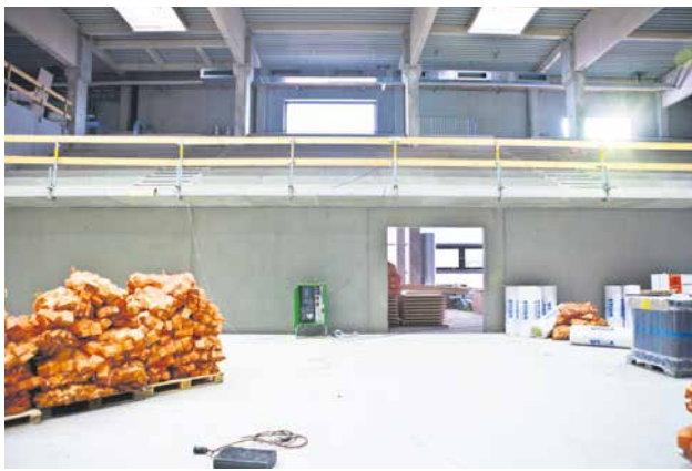
Die ehemalige IGS-Blumenhalle wird bis Oktober zur Basketballarena umgebaut
