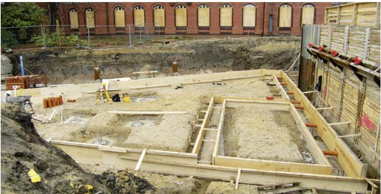
Einbau der horizontalen Flächendränage und der Fundamentdurchbrüche
