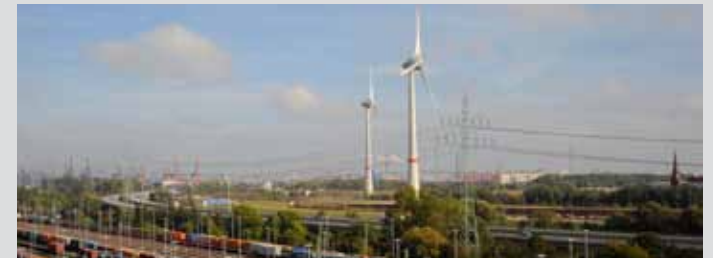
54 Wind turbines, Altenwerder
