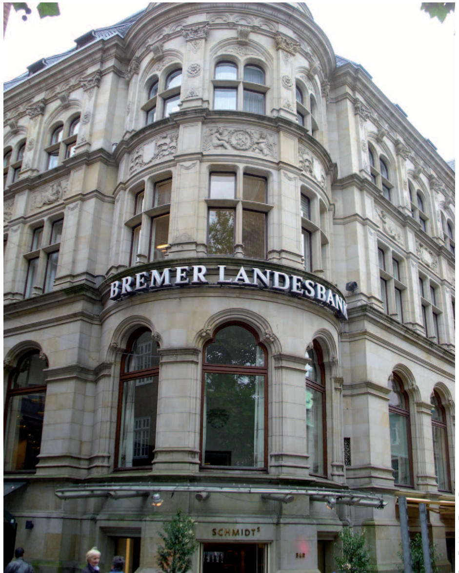
Die denkmalgeschützte Altfassade bleibt erhalten.
