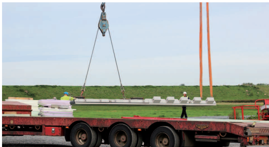
Die Wandelemente können von den Tiefladern direkt in den Turm gehoben werden.
