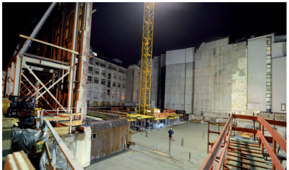
Auf der Baustelle im Februar 2014.
