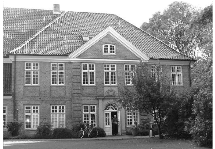
Das Kulturzentrum Stavenhagenhaus an der Frustbergstraße / Ecke Warnckesweg, das 2012 sein 50-jähriges Bestehen feierte, von der Nordseite gesehen: mit dem Eingang, darüber das Wappen der Familie Tieffbrun mit dem Baujahr 1703 (s. Titelbild). Das markante Baudenkmal zeugt davon, dass sich Eibert Tieffbrun als einer der ersten Hamburger Bürger ein Mansardendachhaus bauen ließ.
