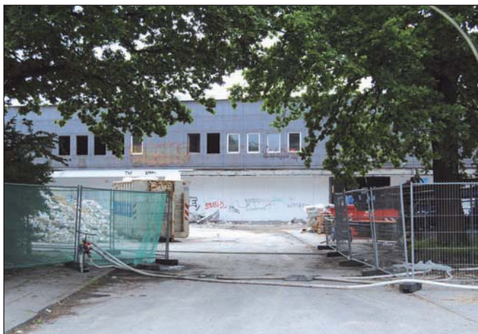
Die Firma Kaufland hat begonnen, die Fassade des alten Karstadthauses ab-zubrechen.
