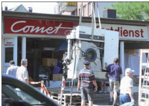
Die alte Reinigungsmaschine verließ den Standort durch das Fenster
