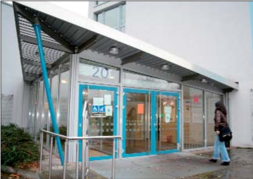
Auch nach der Schließung des Ortsamtes ändert sich für die Bürger nichts: Kundencenter, Grundsicherungs- und Bauprüfabteilung bleiben an der Herthastraße 20.
