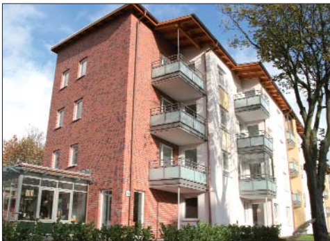
Die neue Senioren-Wohnanlage der SAGA/GWG
