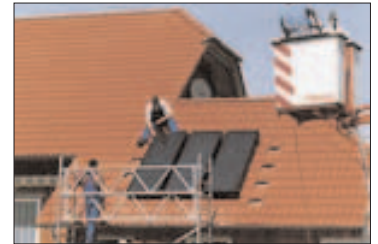
Sonnenkollektoren-Montage
