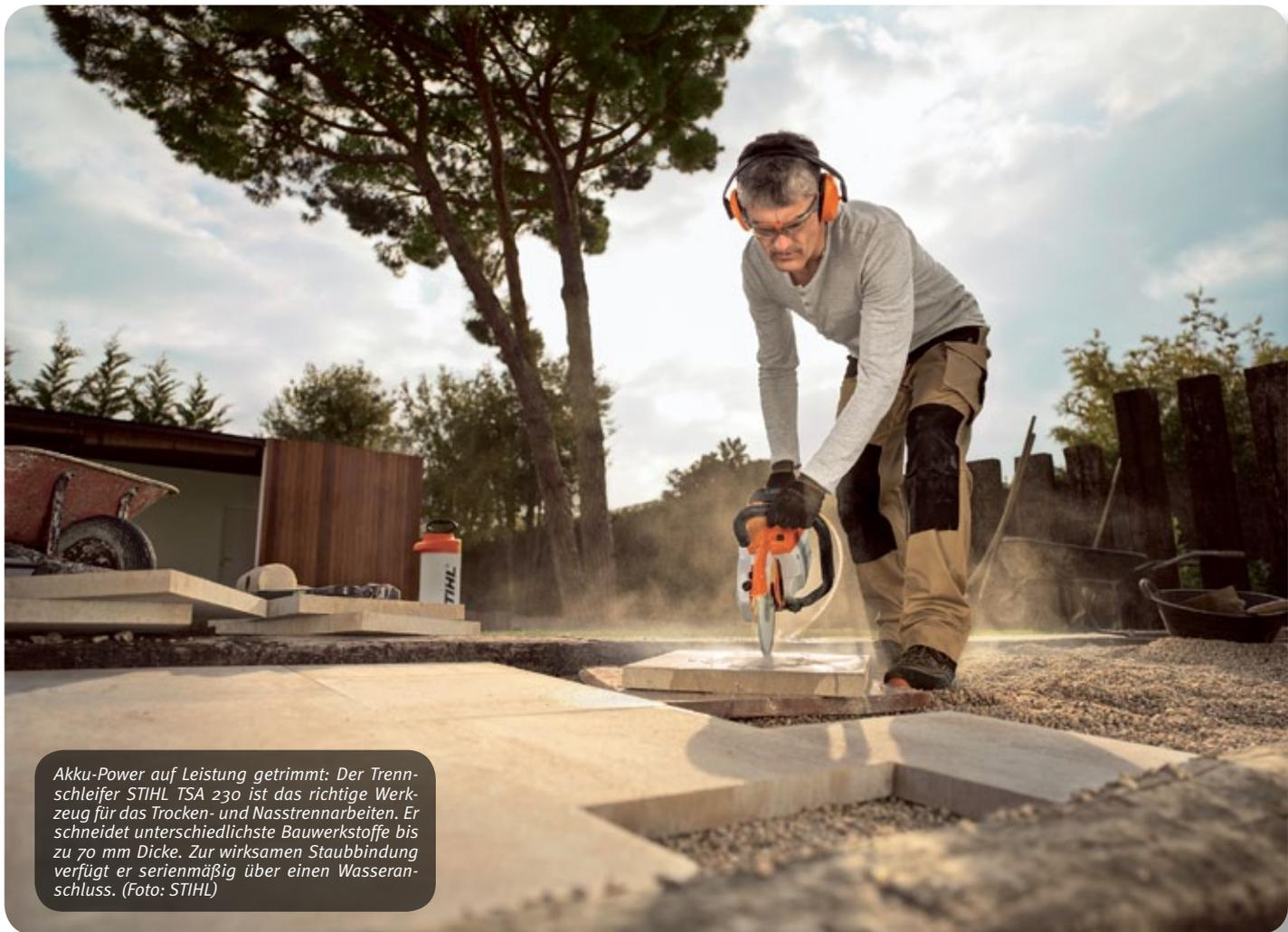
*Akku-Power auf Leistung getrimmt: Der Trennschleifer STIHL TSA 230 ist das richtige Werkzeug für das Trocken- und Nasstrennarbeiten. Er schneidet unterschiedlichste Bauwerkstoffe bis zu 70 mm Dicke. Zur wirksamen Staubbinding verfügt er serienmäßig über einen Wasseranschluss. (Foto: STIHL)*
