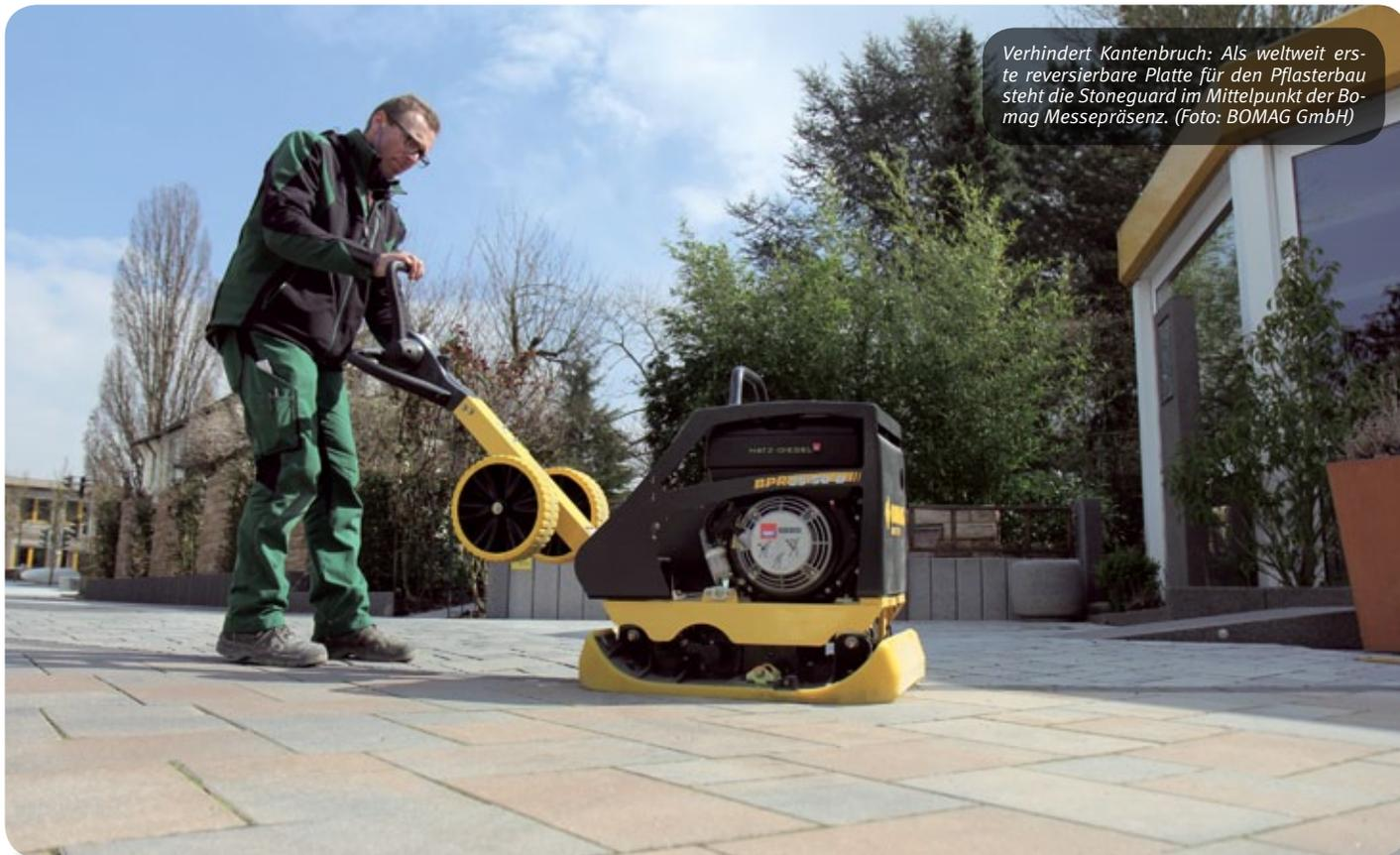
Verhindert Kantenbruch: Als weltweit erste reversierbare Platte für den Pflasterbau steht die Stoneguard im Mittelpunkt der Bomag Messepräsenz. (Foto: BOMAG GmbH)
