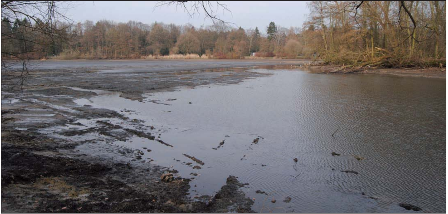
Warten auf das Wasser: Rund um die Vogelinsel wurde der Faulschlamm ausgehoben. Nun soll wieder Wasser in den Bramfelder See gelassen werden.
